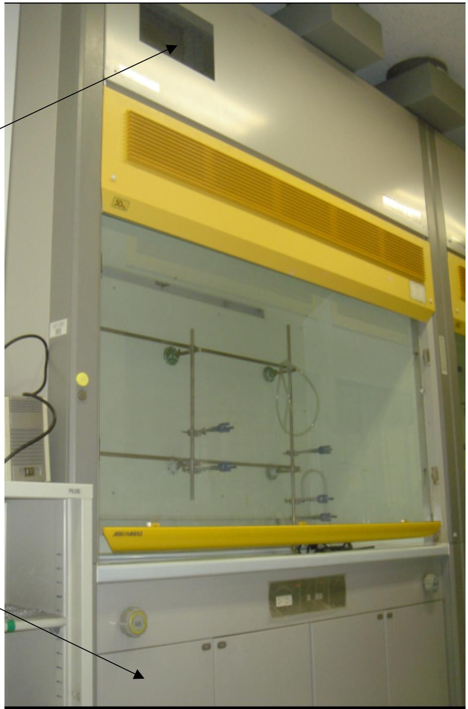
メインフィルターの汚れ、破損を確認
