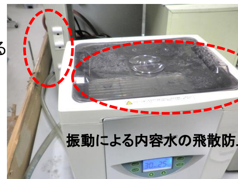
近隣コンセントの使用状況
