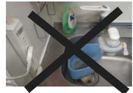
電源タップは水がかからない場所に設置してください。
