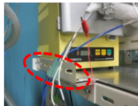
アングルの落下防止策
